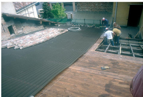
Tetto della navata centrale con sostituzione delle travi lesionate, recupero delle piastrelle in cotto, copertura con onduline e coppi.
