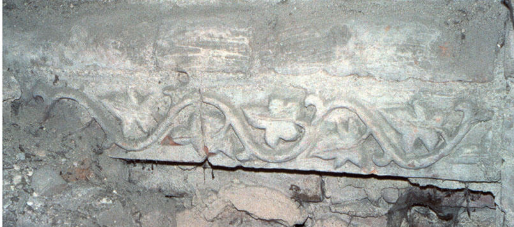
Tralcio di vite in cotto, prima metà del XV secolo, sottotetto abside-base del campanile
