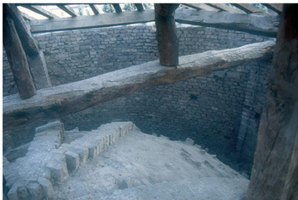
La volta dell'abside, una volta liberata dal rottame che la copriva fino alla base delle cariatidi
