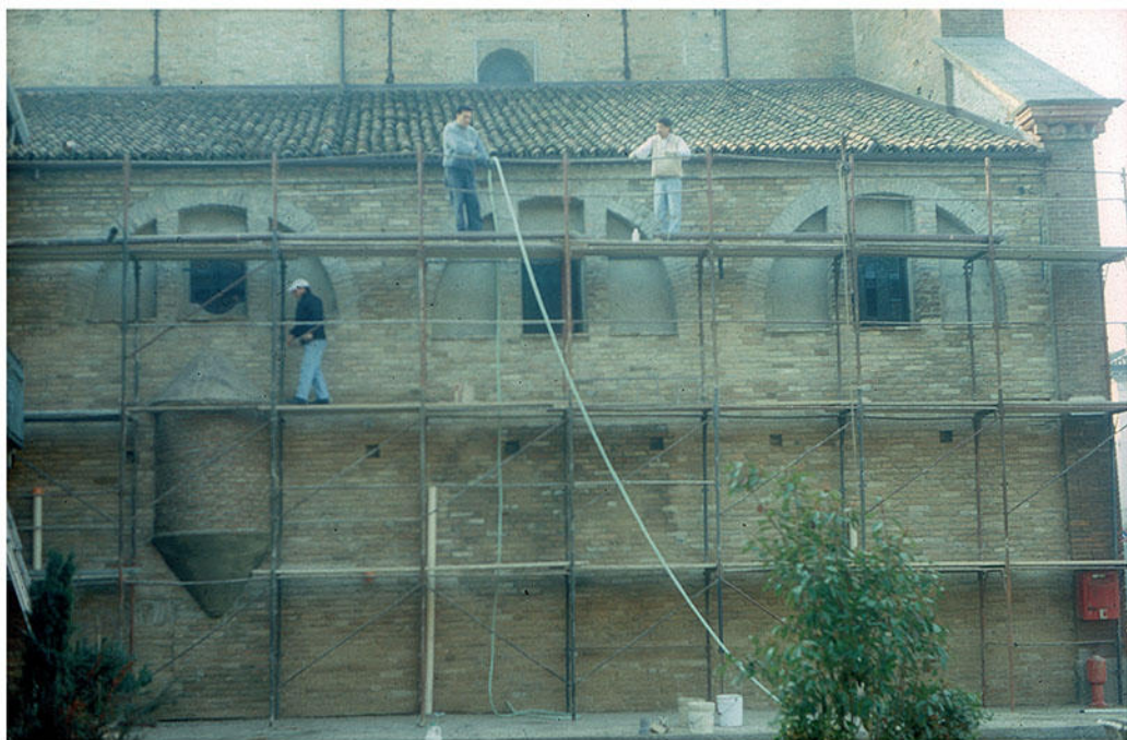
Primavera 1997, avvio e conclusione dei lavori sulla fiancata settentrionale
