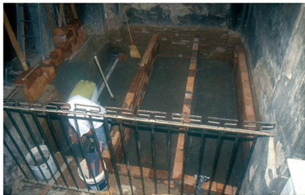
Battistero: dopo lo scavo vengono creati due strati di camere di aerazione
